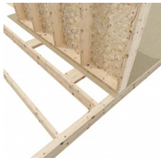
Wzmocnienie ścian szkieletowych
