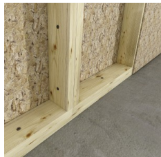
Łączenie ścian szkieletowych
