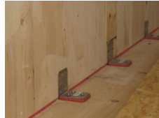
Exemple de mise en œuvre
