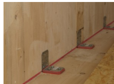
Exemple de mise en œuvre
