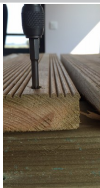
3. Plaquage de la lame sur la lambourde
