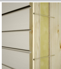
Assemblage de montants pour la réalisation d'ITE
