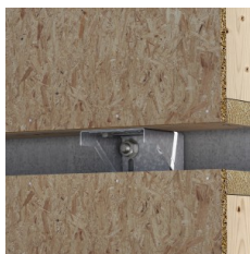
Holzkonstruktion unter dem Konsolwinkel an der Deckenschmalseite.
