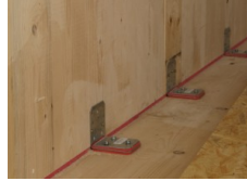
Exemple de mise en œuvre
