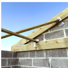
Gekruiste windverbanden voor hout
