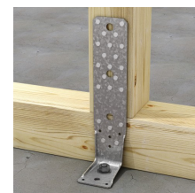
Fastsättning med SDS skruvar
