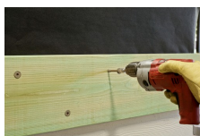
Fixação de elementos de madeira no exterior
