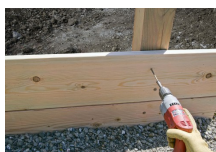
Fixação de elementos de madeira no exterior
