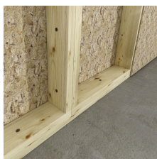
Łączenie ścian szkieletowych
