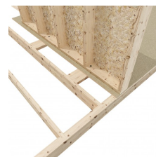
Wzmocnienie ścian szkieletowych
