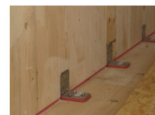
Exemple de mise en œuvre
