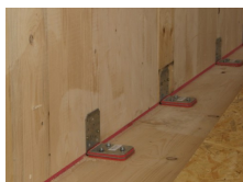
Exemple de mise en œuvre
