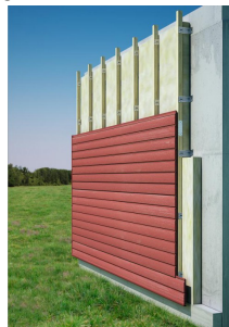
Mise en place d'un pare-pluie
