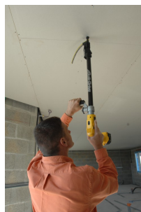
Vissage sur plafond en plaque de plâtre.
