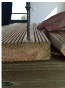
2. Ruiming van boorgat en snelle bevestiging
