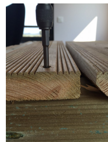
3. Vastklemming van de plank op de vloerbalk
