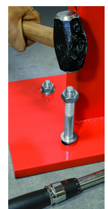
Fixation de structure métallique
