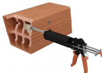
Inject the resin.
