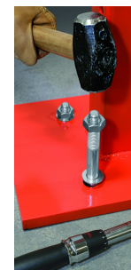
Fixation de structure métallique
