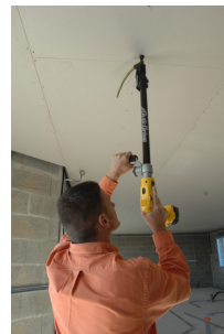
Vissage sur plafond en plaque de plâtre.
