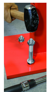
Fixation de structure métallique
