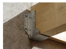
Fixation de structure bois
