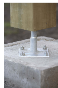
Fixation d'un pied de poteau
