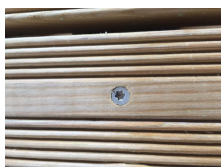
4. Huit nervures sous tête pour une finition parfaite
