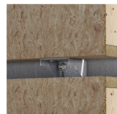
Asennus kahden puuelementin väliin
