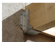
Fixation de structure bois
