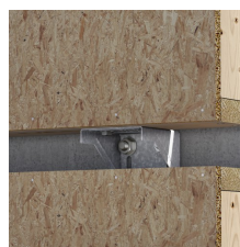
Holzkonstruktion unter dem Konsolwinkel an der Deckenschmalseite.
