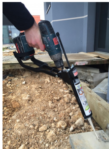
Anwendung mit Injektionsmörtel
