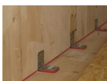
Exemple de mise en œuvre
