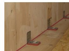
Exemple de mise en œuvre
