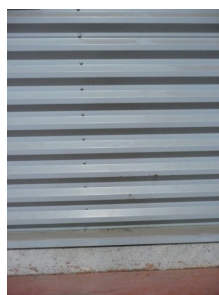
Fixation de bargage métallique
