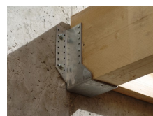
Fixation de structure bois
