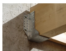
Fixation de structure bois
