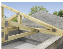
Verbinding van de kapspanten
