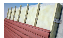
Mise en place éventuelle d'un pare-pluie
