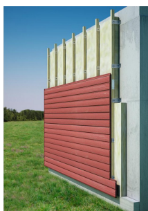
Plaatsing van een regenkap
