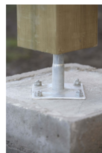
Fixation d'un pied de poteau
