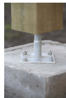
Fixation d'un pied de poteau
