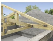
Assemblage des fermettes
