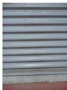
Fixation de bardage métallique
