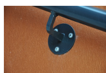
Fixation de support de rampe
