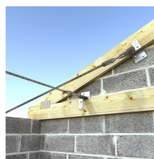
Tendeur de feuillard FMBS fixé sur connecteur CST
